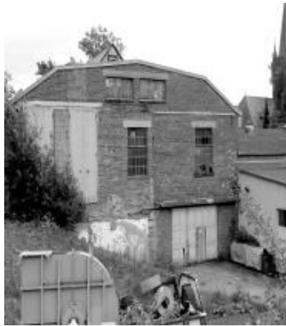
Besichtigungsobjekt Halle 411 auf ehemaligem Werksteil 4 der Fa. Schilde.
